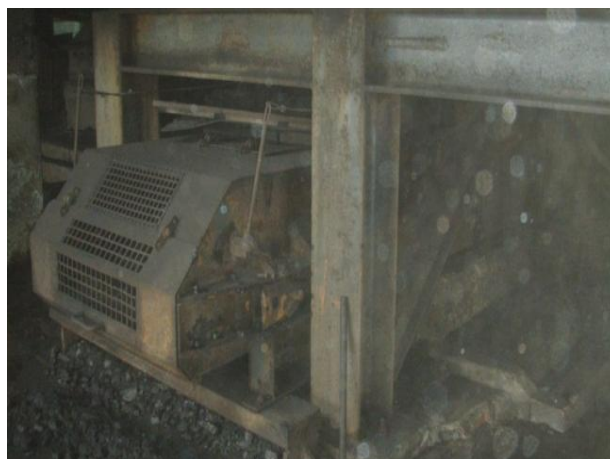
Rys. 1. Obudowa przesypu z kruszarki WUB-100 [7]
